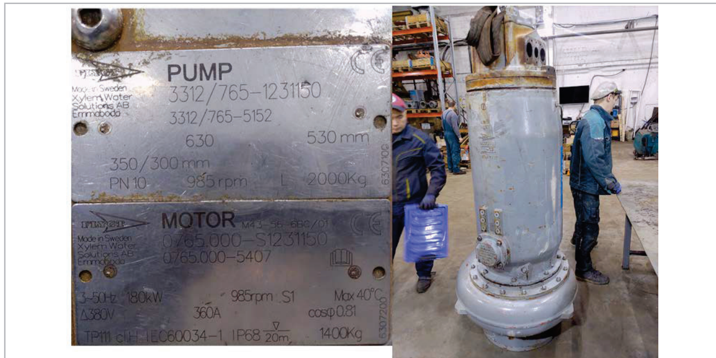
Фото 1: Общий вид и шильд насоса
